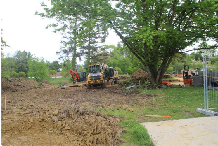
Les travaux des parkings sont en cours
