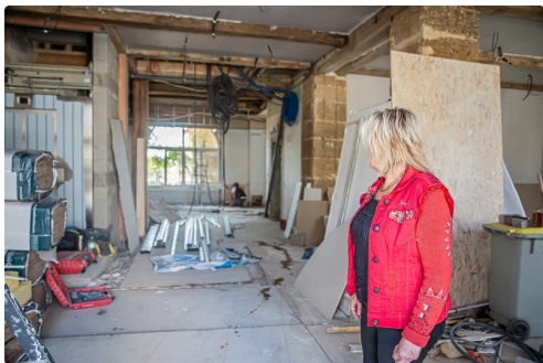
Patricia Galabert montre les vastes combles
