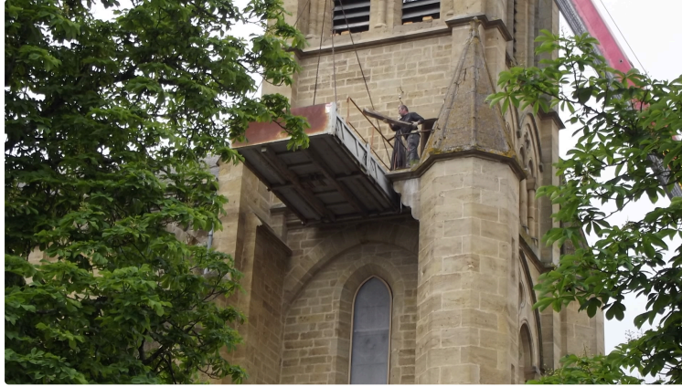
Poursuite des travaux à l'église
