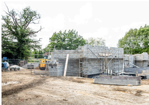
Le bâtiment destiné à l'accueil et aux bureaux, en construction
