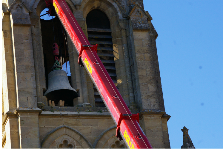
Dans le cadre de la rénovation de l'église
