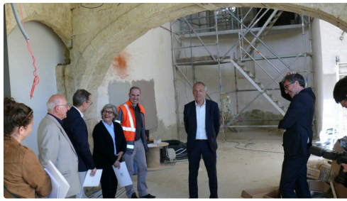
Les travaux ont dévoilé une voûte qui était murée.
