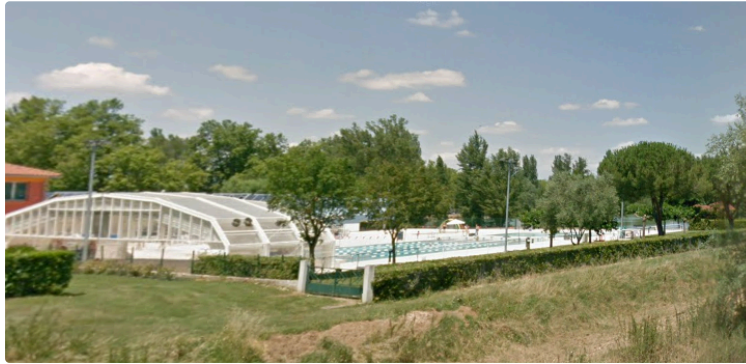
Ouverture de la piscine intercommunale
