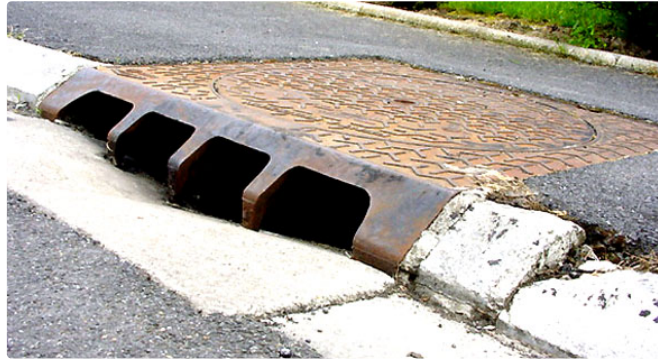
Des tests à la fumée dans les canalisations
