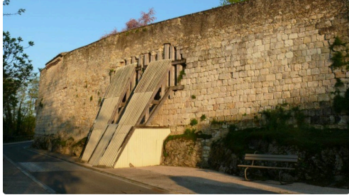
L'étaie de rempart situé au droit du jardin du Carmel.
