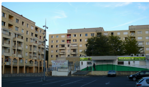
Les immeubles Porthos et d'Artagnan ceinturent la place de la Fontaine.
