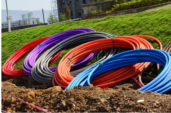
Déploiement de la fibre optique
