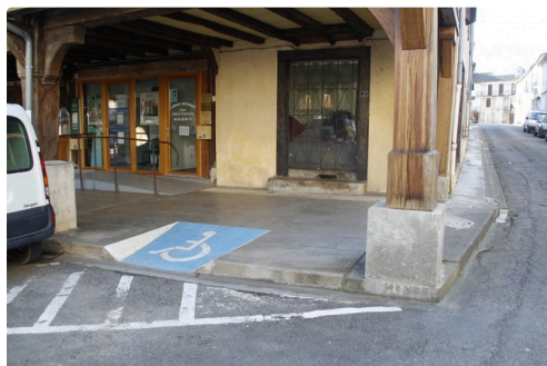
Rampe d'accès place de la mairie.
