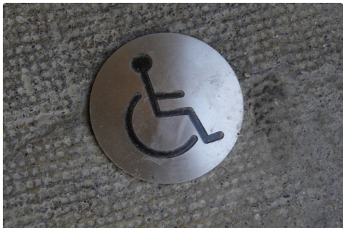
Marquage au sol.
