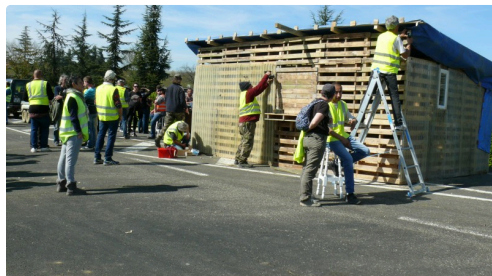
Construction de "La maison citoyenne".
