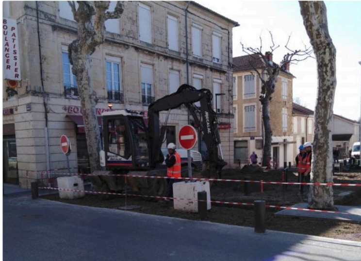
Finalisation des travaux du centre ville de Vic-Fezensac
