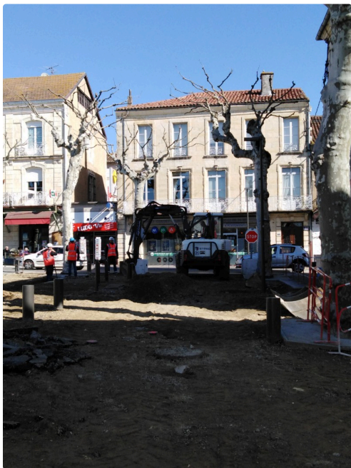
Travaux au centre ville
