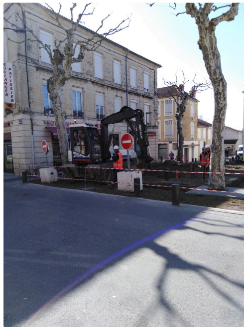
Travaux au centre ville
