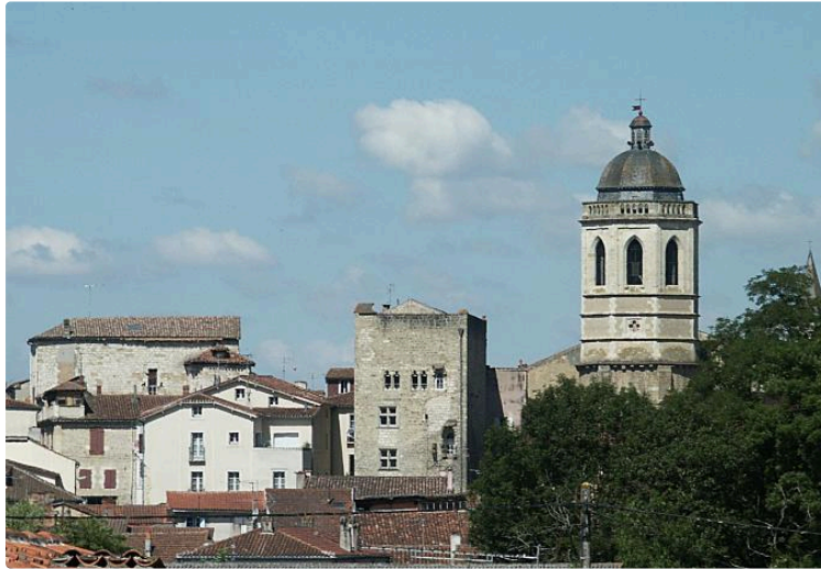
"L'église Saint-Pierre, ancienne collégiale de Vic-Fezensac"
