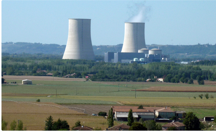
Centrale nucléaire de Golfech
