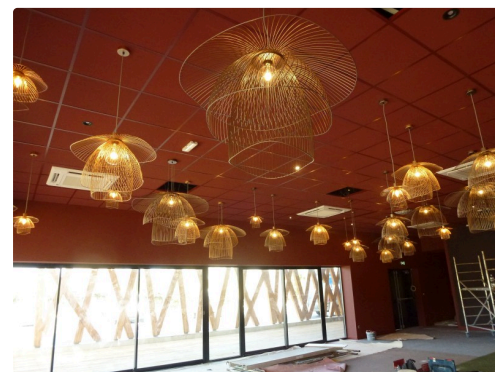
L'entreprise Ligardes peaufine les dernières installations électriques.
