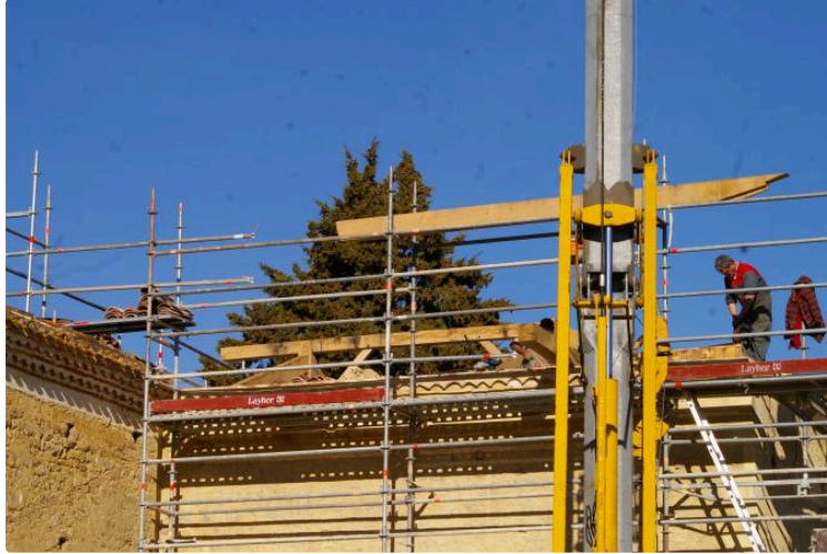
Église de Tasque en travaux de réhabilitation
