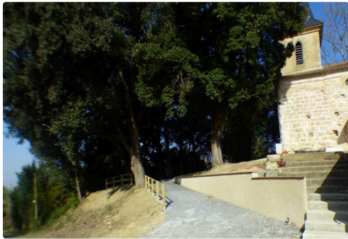
Une entrée accessible pour tous.
