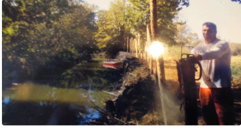
les travaux sur la berge du Boués
