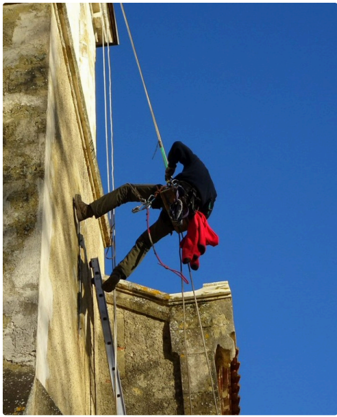
Descente en rappel avant d'atteindre l'échelle
