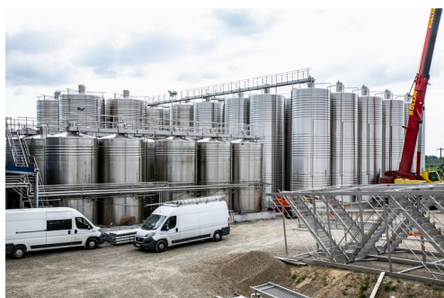
La nouvelle cuverie (60 000 hl)
