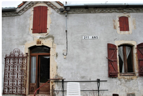
A Tarsac, la façade de la maison de Roland Larrieux.
