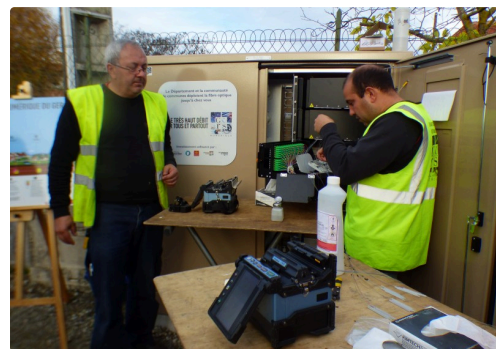
Le raccordement de fibres optiques un travail très minutieux
