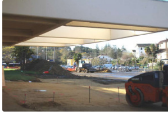
La deuxième tranche des travaux a débuté
