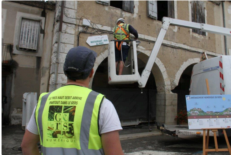
La mise en service de la fibre optique est programmée au 20 novembre
