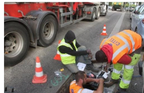
Pose du câblage. (Photo : Marc Le Saux).
