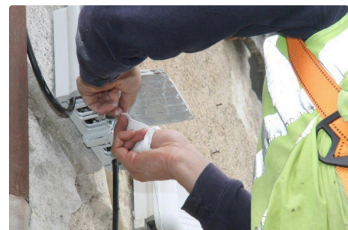
Le branchement est en cours.
