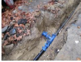
Modernisation du réseau d'eau potable
