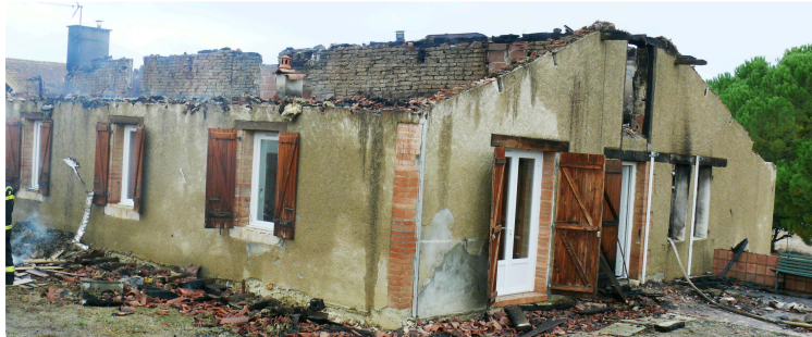
Un incendie embrase totalement une maison d'habitation
