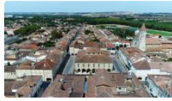
Travaux en centre-ville
