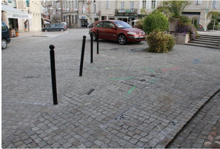
Travaux en centre-ville
