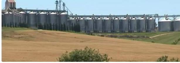
Inauguration des nouveaux silos de Nataïs
