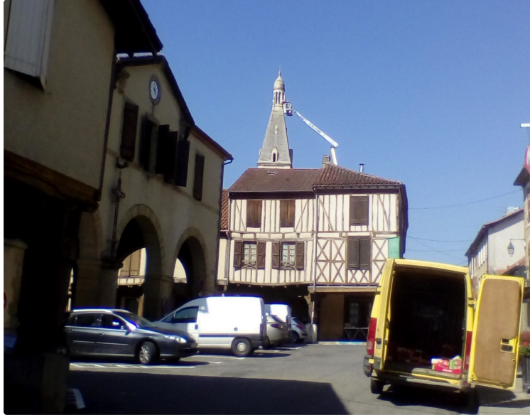
Un chantier vertigineux
