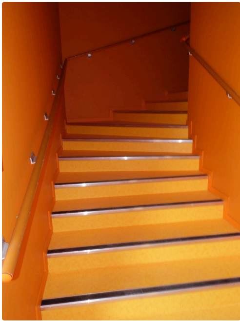
L'escalier intérieur du bâtiment principal
