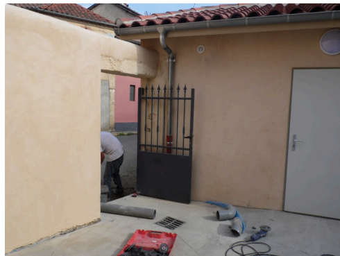
Le portillon d'accès à la cour de la chaufferie l'est aussi
