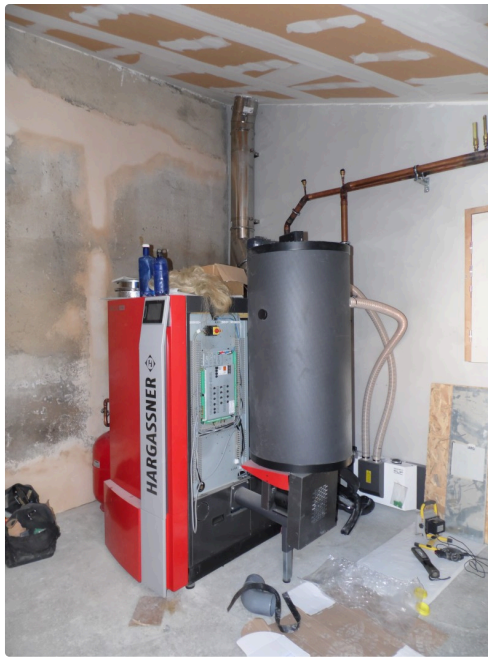
La chaudière a été mise en place par Stéphane Puntous chauffagiste le seul Plaisantin qui travaillait sur la chantier
