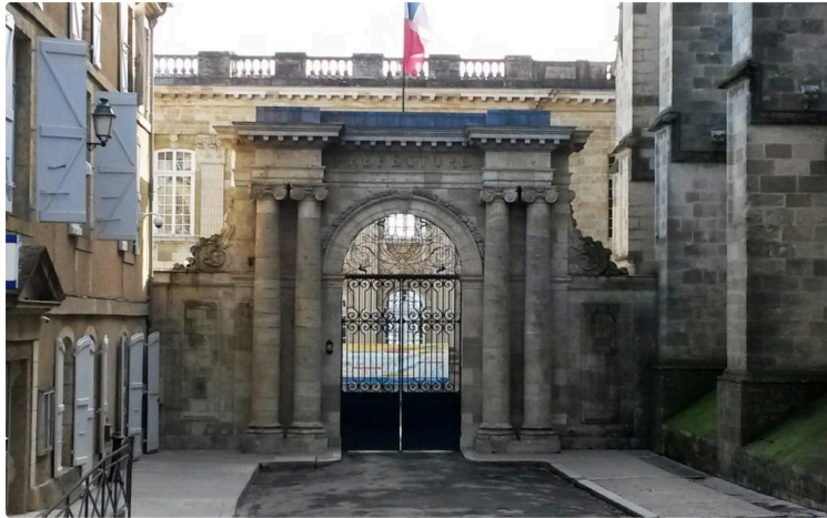
Fermeture exceptionnelle des services « migration et intégration » et « environnement » de la préfecture du Gers
