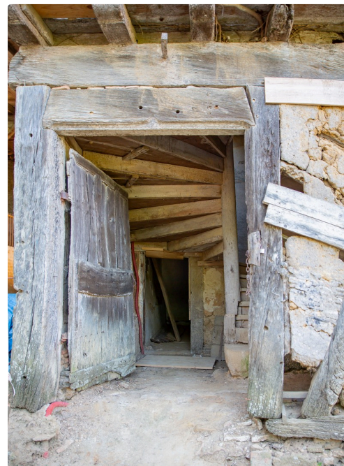
...avec la porte donnant sur l'escalier
