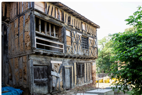
Façade arrière du Castet...
