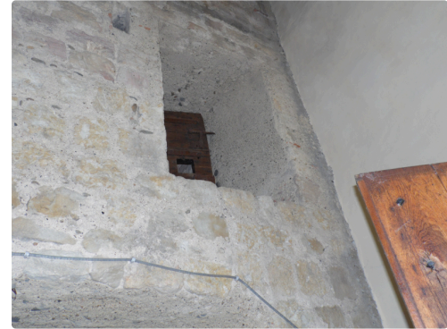
La porte extérieure de la prison , un escalier disparu en permettait l'accès
