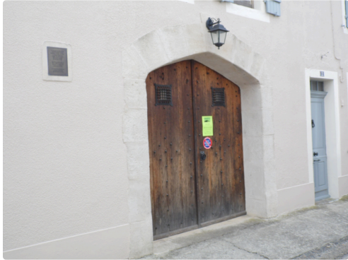
L'imposante porte d'entrée de la tour
