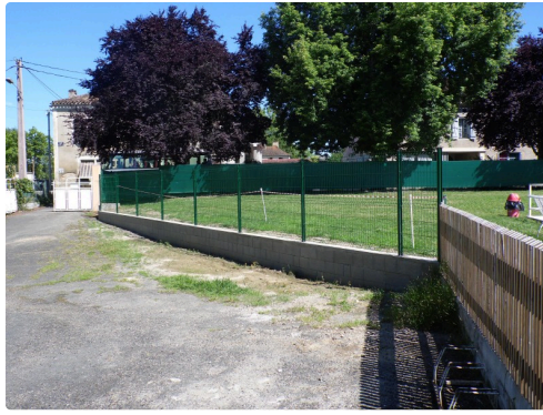
Un aménagement solide pour délimiter l'espace pelouse
