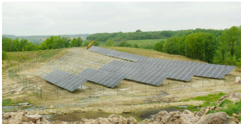
500 panneaux photovoltaïques sont posés sur les 832 prévus.
