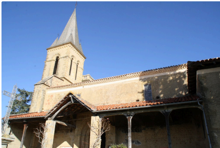
Sainte Dode : Rénovation des peintures murales de l'église.
