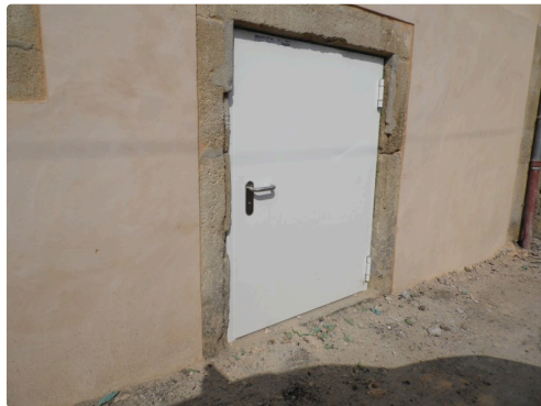
L'entrée de l'ancienne cave côté Rue Basse sécurisée : Photos Marcel Lavedan début mai 2018 Haut de page coté rue Sainte-Quitterie
