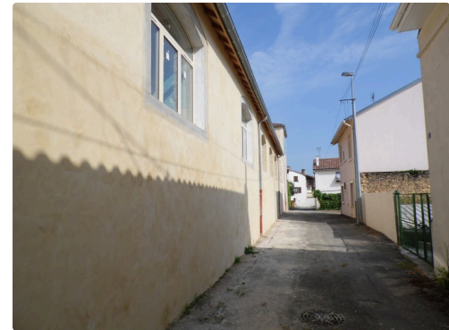
Les enduits terminés côté "Rue Basse"
