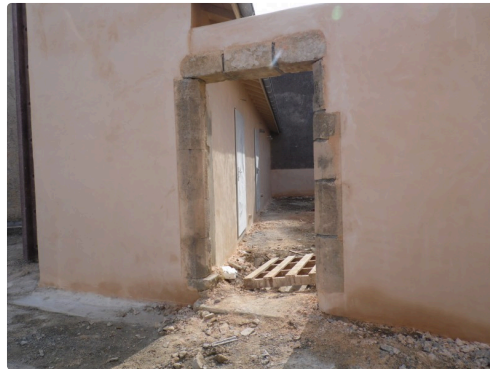
L'entrée de l'espace de la chaufferie refaite à l'identique
