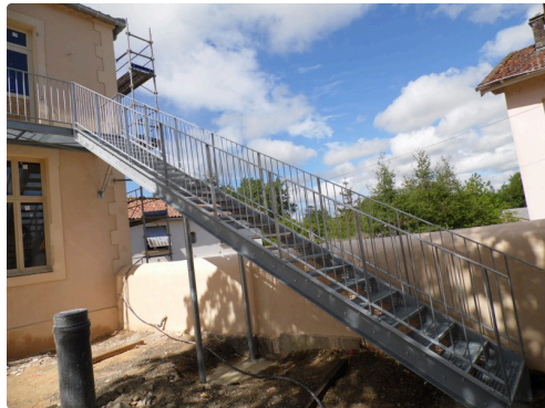
L'escalier de secours incendie est posé
