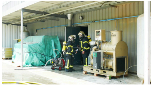
Intervention des sapeurs pompiers pour effectuer le relevé de monoxyde de carbone.
