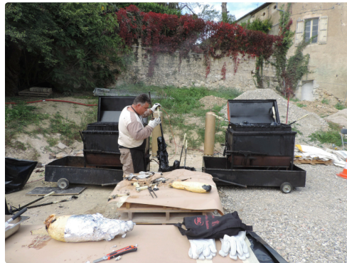
Le " gigot bitume" une spécialité de cuisson remise au goût du jour par les ouvriers du gros oeuvres des chantiers .
