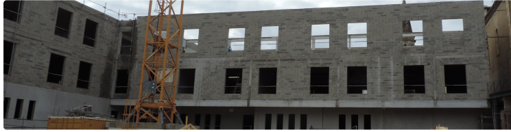
Condom les travaux en bonne voie
