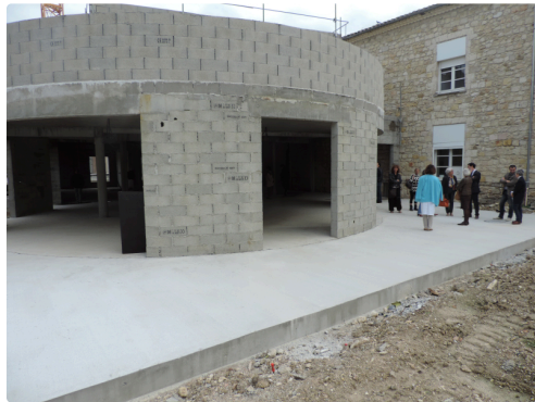
Visite du chantier dont la future salle à manger qui ouvre sur l'extérieur
