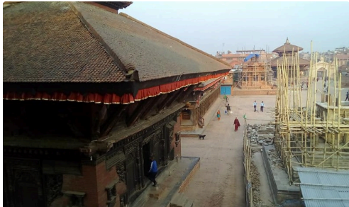
Baktapur, un site encore en reconstruction.
