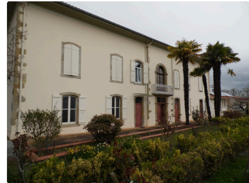
Le bâtiment originel de l'hospice de 1936 abrite maintenant les religieuses
