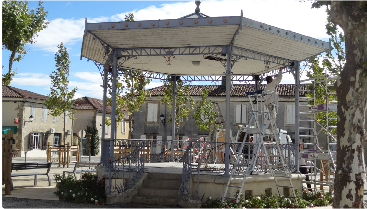
Inauguration de la place Carnot après de gros travaux
