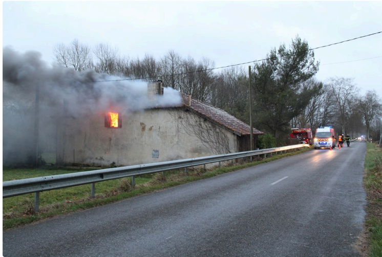
Une habitation détruite par un incendie.
