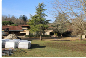
Le grand chantier a débuté
